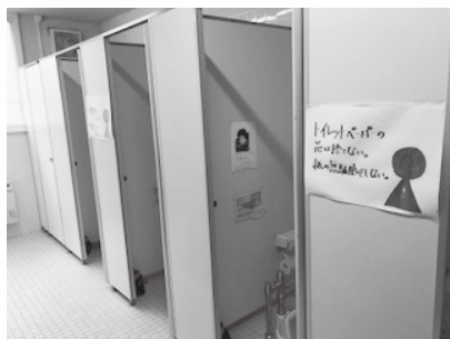
和式便器が並ぶ中学校トイレ
